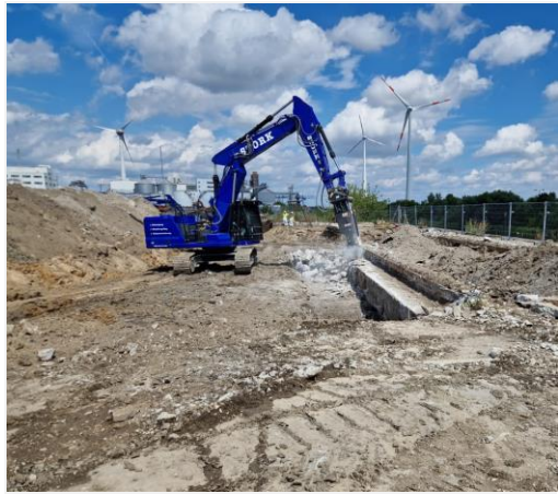
Sanierung gemäß Sanierungsplanung der LAF
