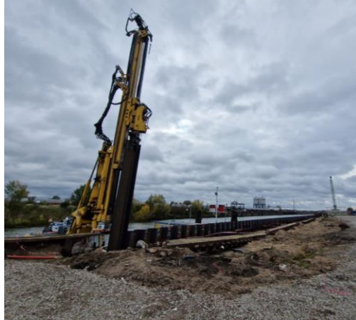
Erneuerung der Spundwand am Ostkai
