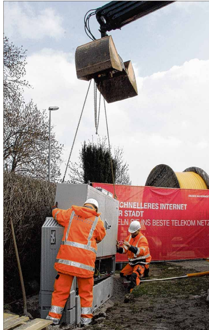
Die Telekom baut in Magdeburg-Nord das Glasfasernetz für schnelles Internet aus. Gestern stellten Peter Friedrich (l.) und Kevin Kegel einen Verteilerkasten an der „Spinne“ in Nordwest auf. Foto: Harter
