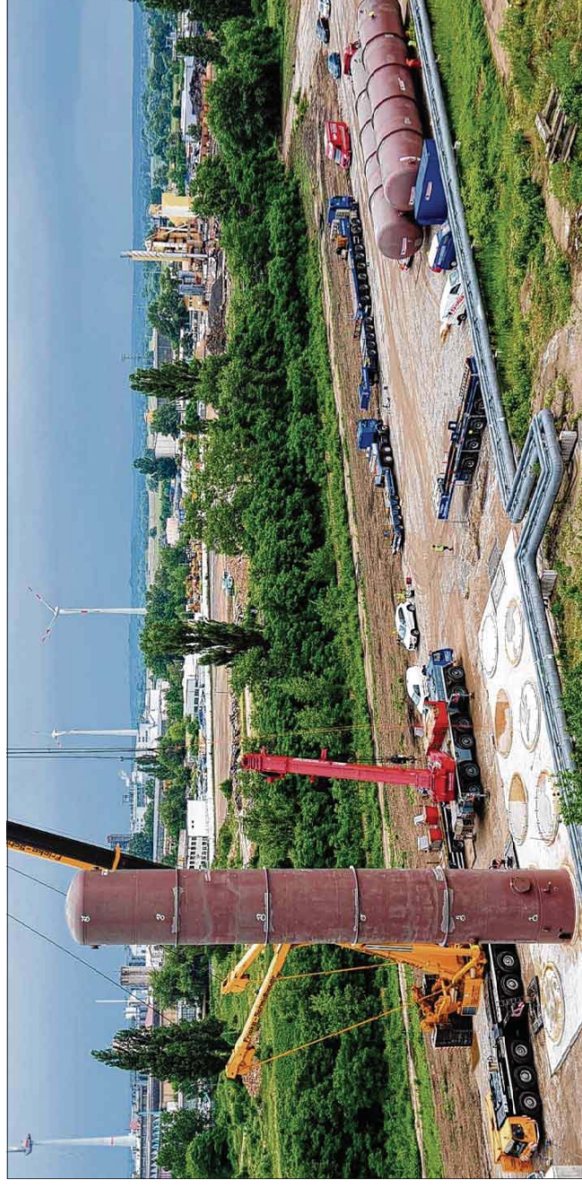
Insgesamt neun Warmwasserspeicher werden derzeit auf dem Gelände des Müllheizkraftwerkes in Rothensee von Spezialfirmen aufgebaut. Jeder dieser riesigen Behälter ist 30 Meter hoch, wiegt etwa 80 Tonnen und hat ein Fassungsvermögen von rund 390 Kubikmetern. Foto: Uli Lücke
