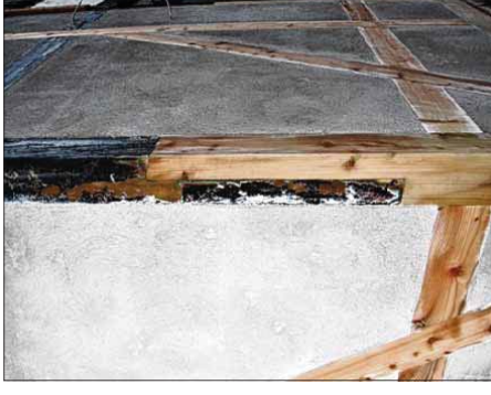
Die Balken des Fachwerks wurden saniert und ergänzt.
