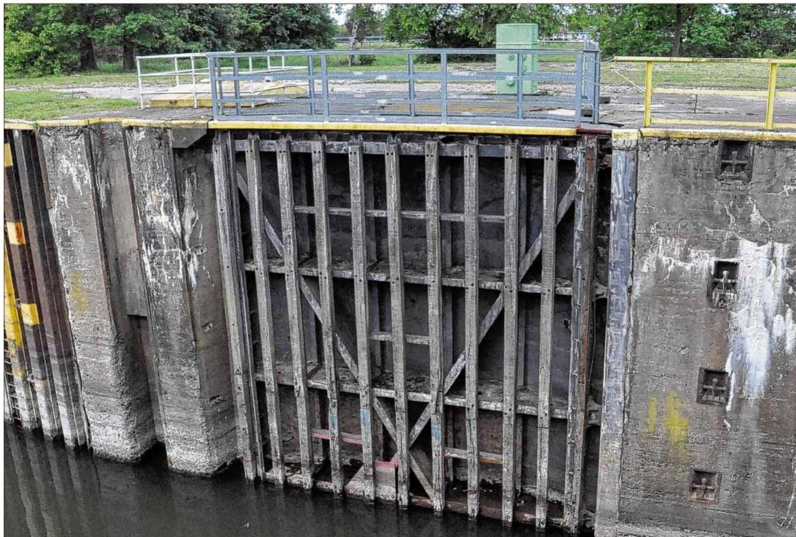
An der unteren Einfahrt zum Schiffshebewerk befindet sich das Stemmtor, an dem Teile ausgebessert werden müssen. Fotos (3): Martin Rieß
