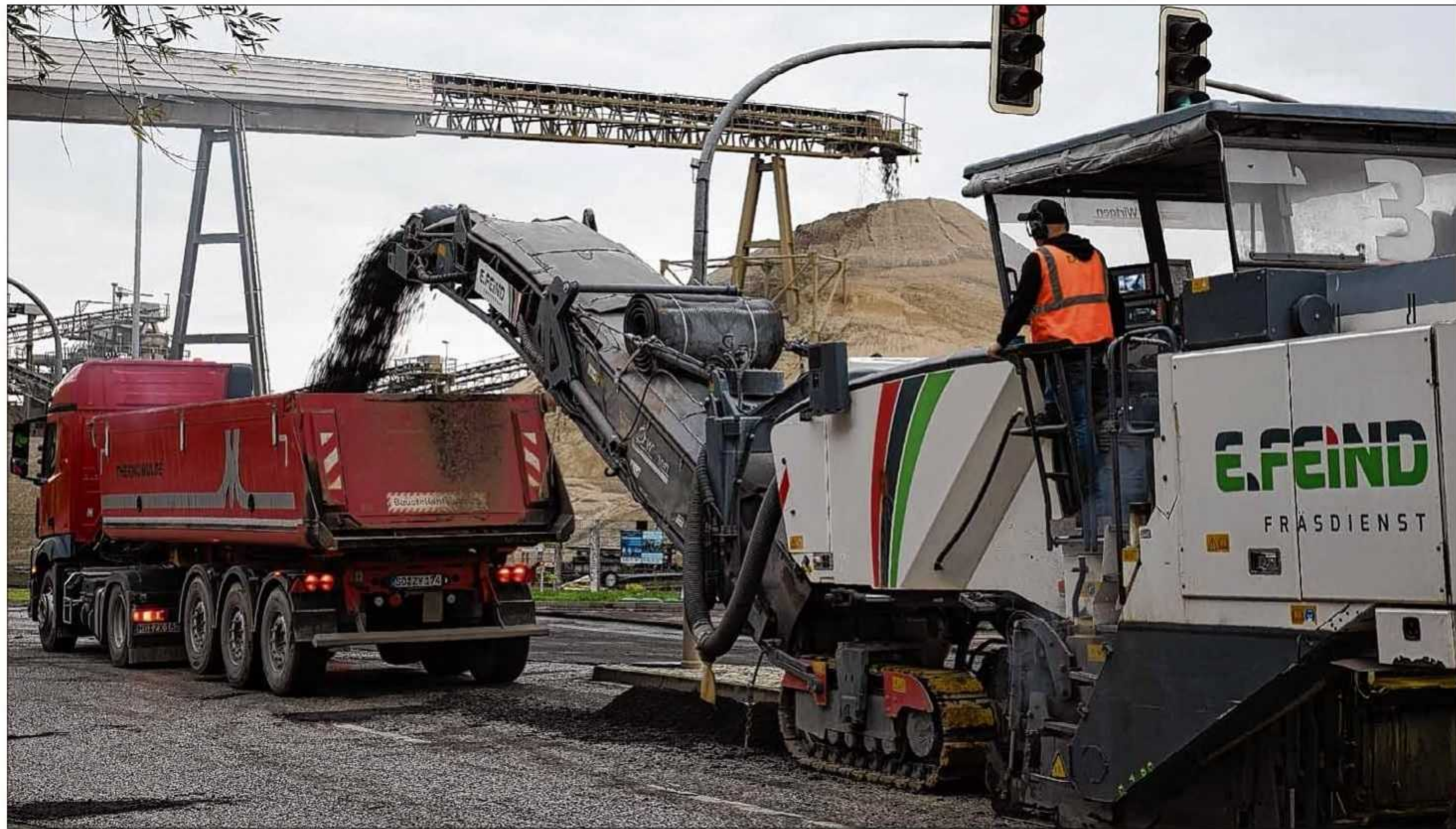
Am Dienstagvormittag frisst sich die Fräsmaschine durch den Asphalt auf dem August-Bebel-Damm. Die Stadt lässt dort die Fahrbahn sanieren und nutzt die gleiche Baufirma, die parallel dazu die Auf- und Abfahrt zur Autobahn A2 instand setzt. Foto: Stefan Harter
