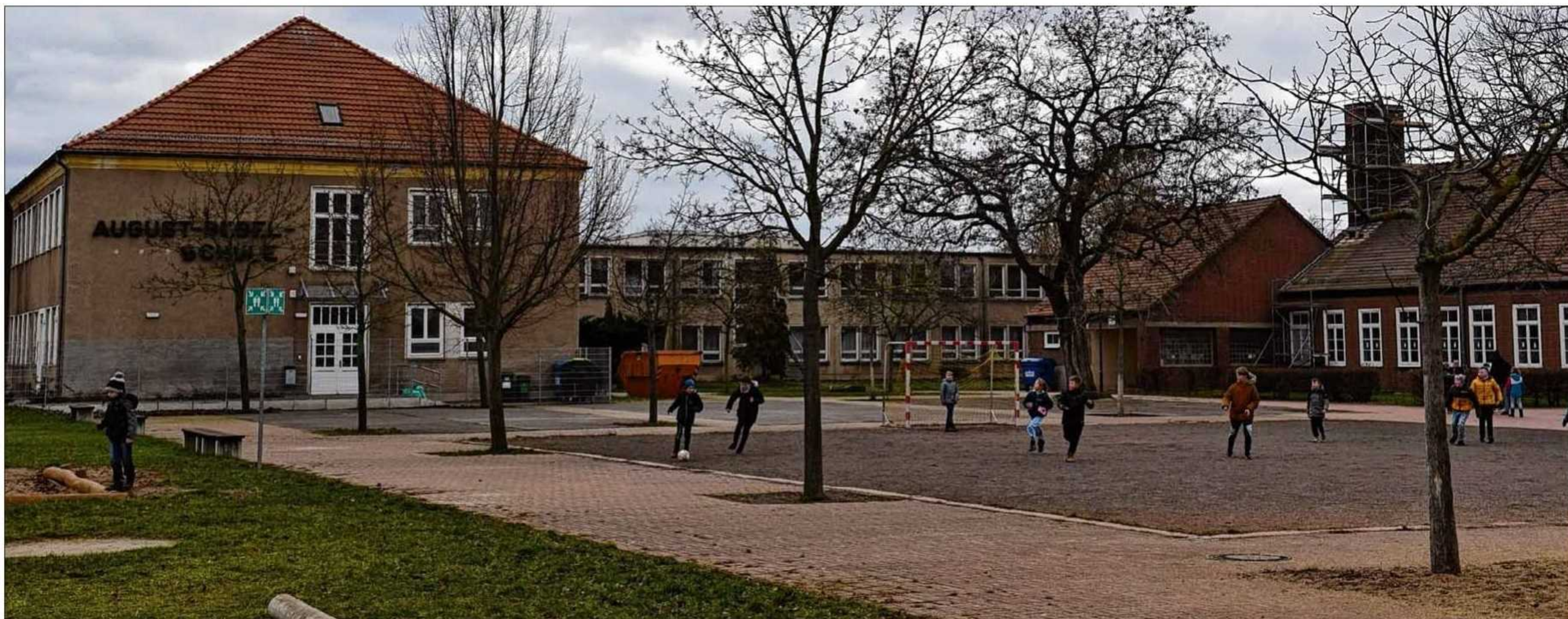
Der Gebäudeteil der ehemaligen August-Bebel-Schule (Bildmitte) soll einem Neubau für den Hort der Rothenseer Grundschule weichen.
