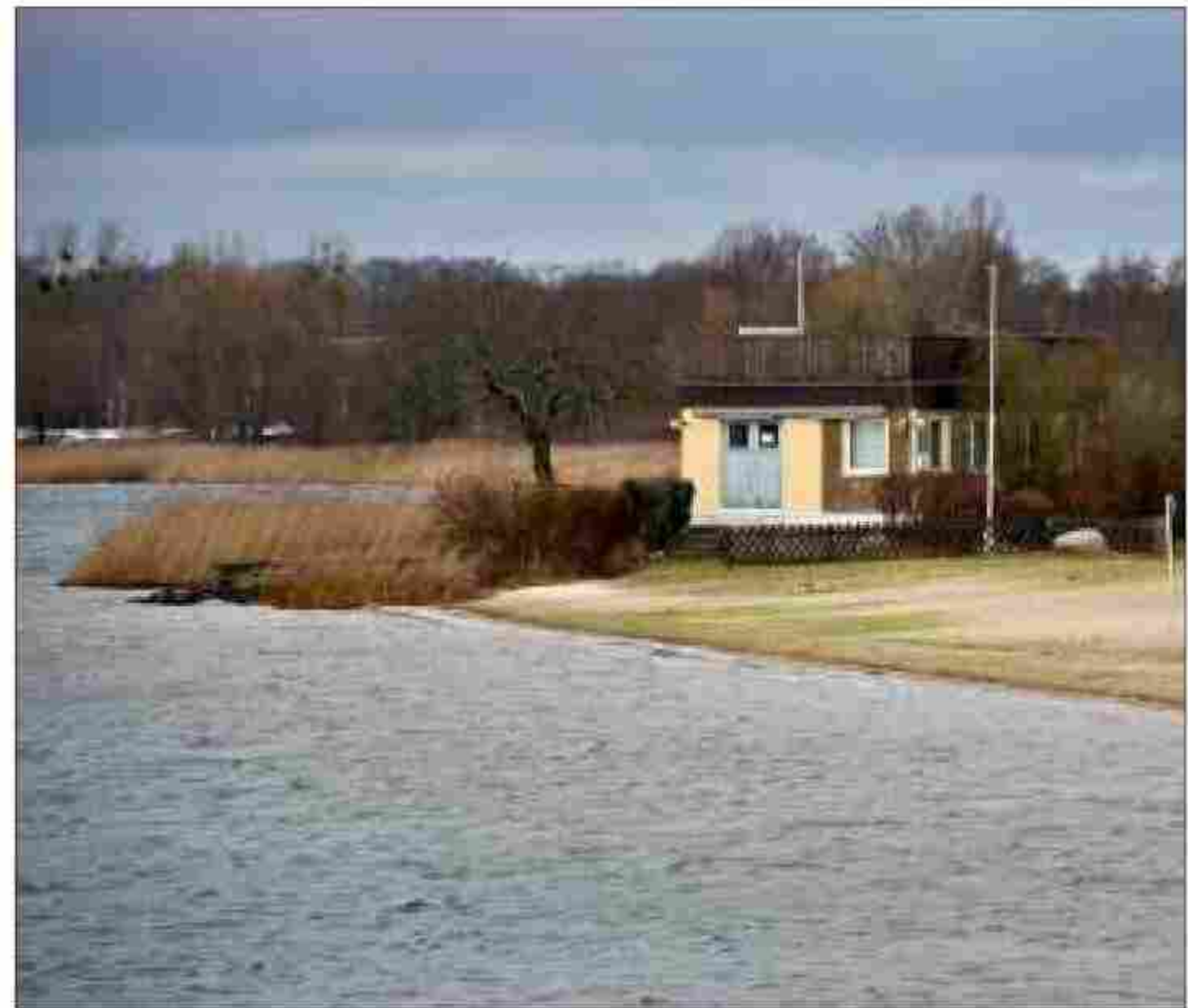
Am Barleber See beginnen in diesem Frühjahr die Rohbauarbeiten für Wirtschaftsgebäude, Rettungstürme, Kassenhäuschen.
