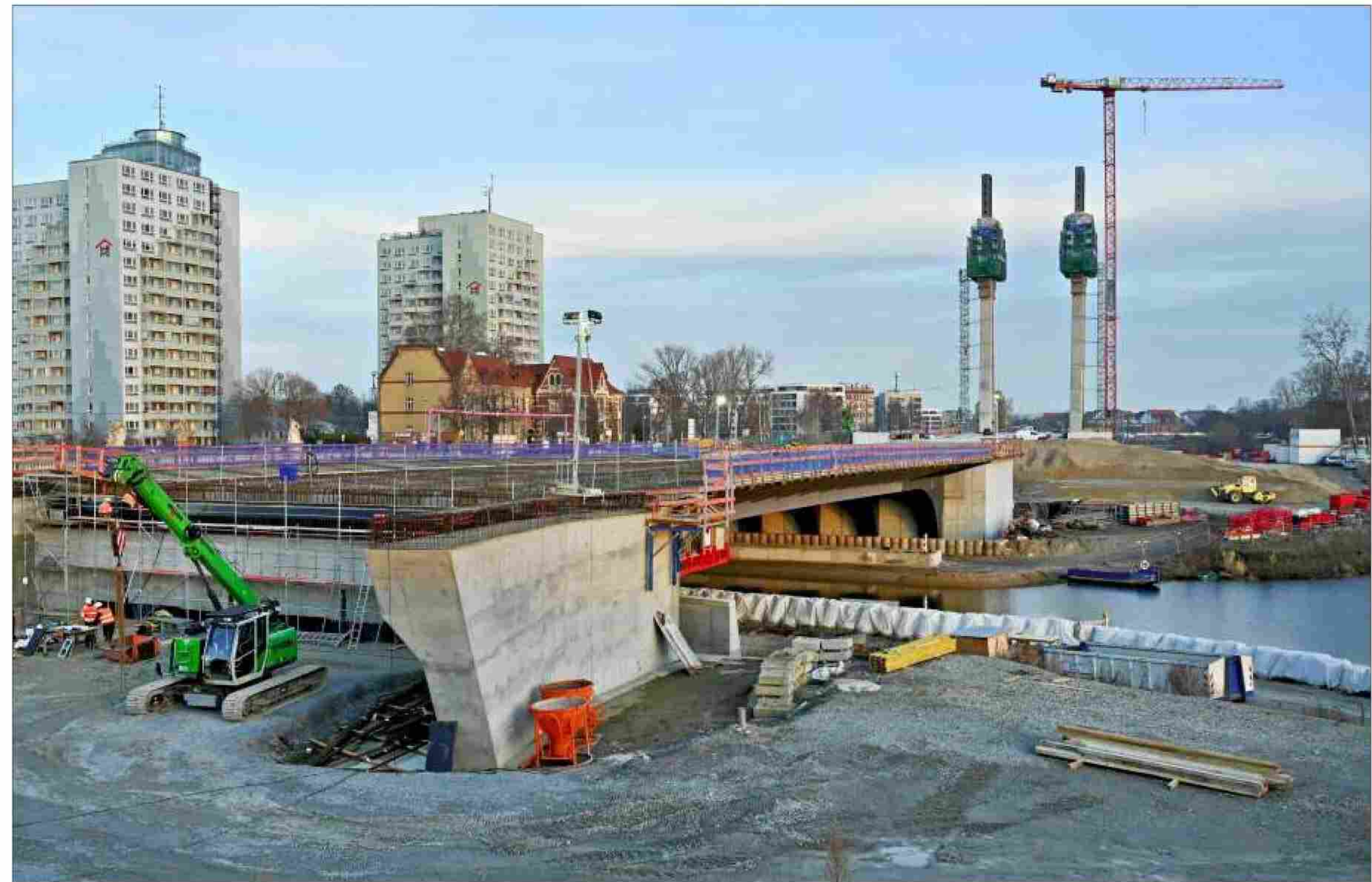
Die Arbeiten am Strombrückenzug gehen auch in diesem Jahr weiter. Ziel ist es, dass Ende des Jahres der Brückenschlag auf der ostelbischen Seite ankommt.
