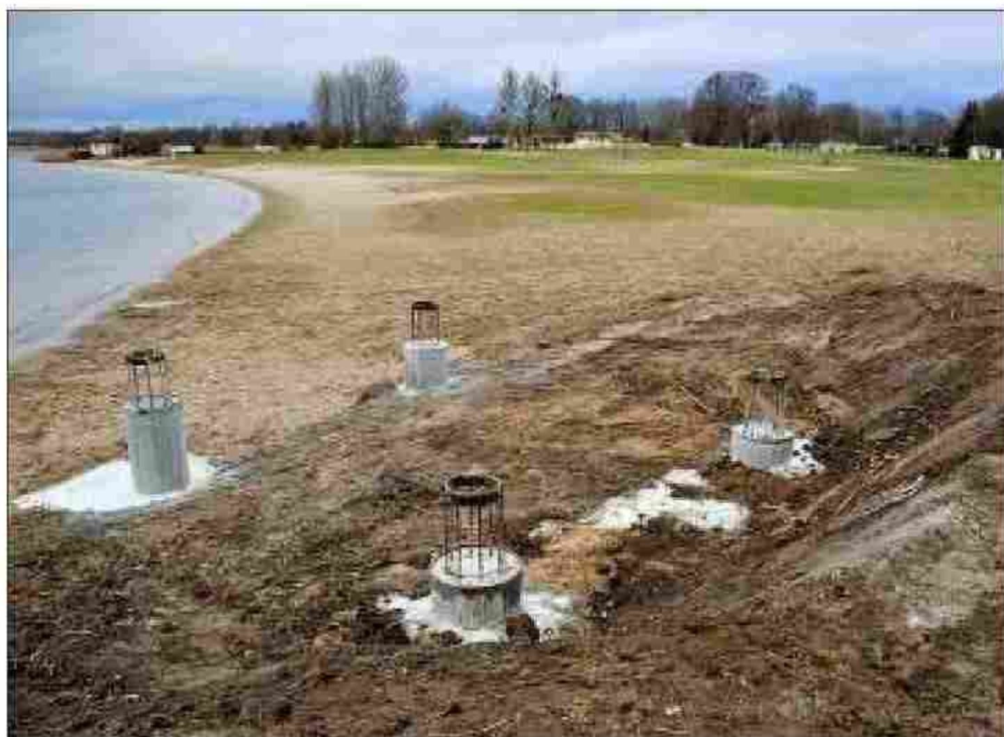
Am Barleber See sind erste bauliche Vorbereitungen für die geplante Umgestaltung des Strandbades zu sehen.
