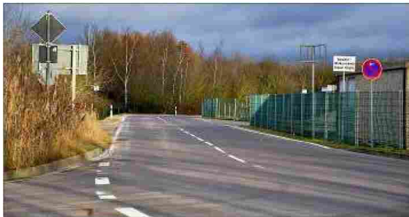
Blick in die Straße Zur Schleuse, die zum Schiffshebewerk Magdeburg führt. In diesem Bereich soll ein Geh- und Radweg entstehen. Foto: Harter
