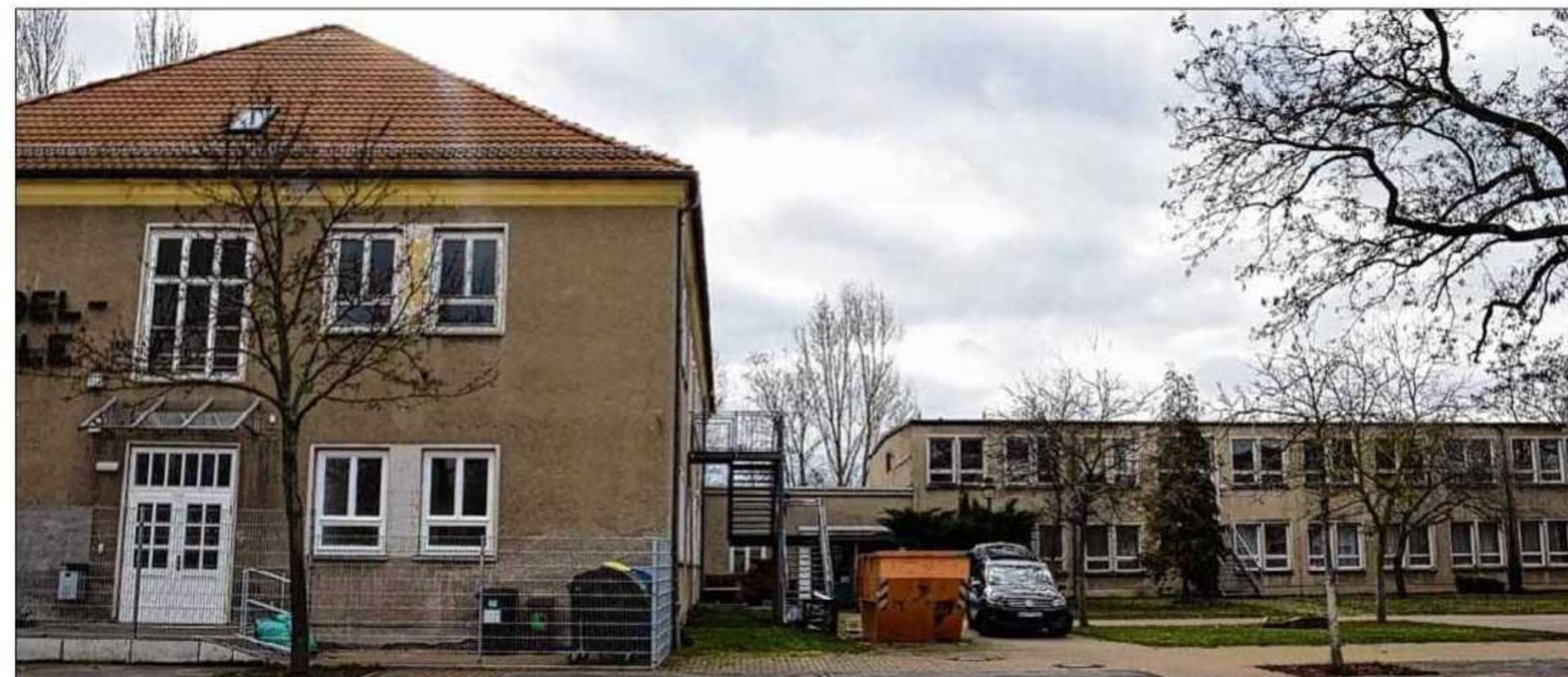
Der seit Jahren ungenutzte Gebäudeteil der ehemaligen Bebelschule (im Bild rechts) soll abgerissen und durch einen Neubau für den Hort der Rothenseer Grundschule ersetzt werden. Foto: Stefan Harter
