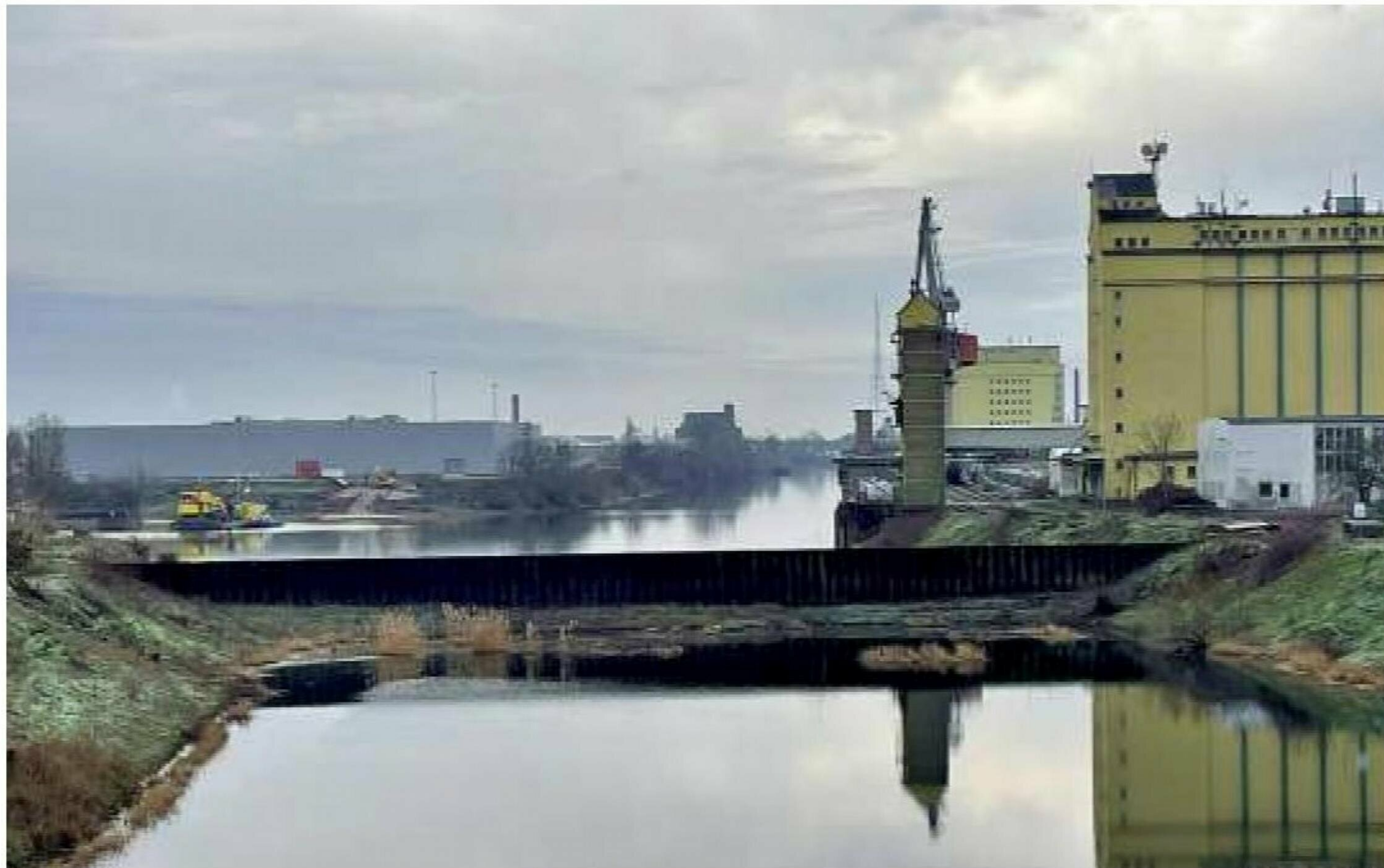
Im Industriehafen entsteht in diesem Jahr viel Neues.
