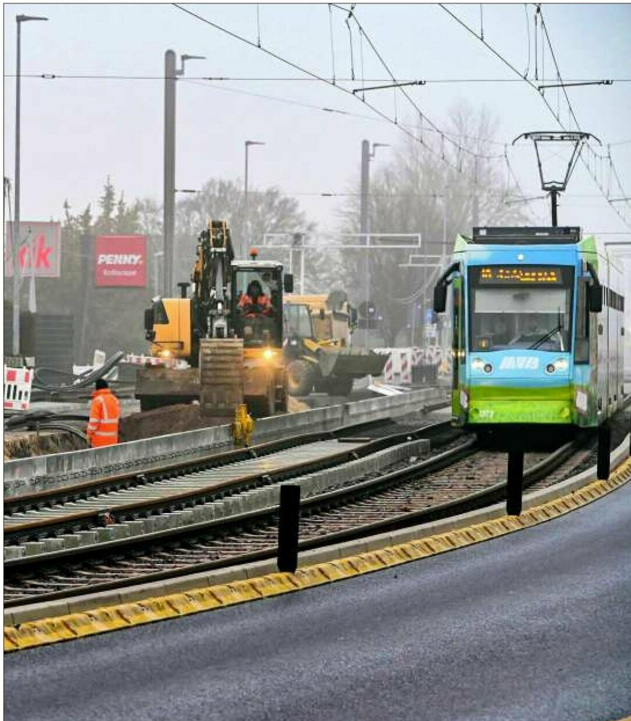
Umfangreiche Straßen- und Gleisbauarbeiten laufen bereits auf dem August-Bebel-Damm in Rothensee.
