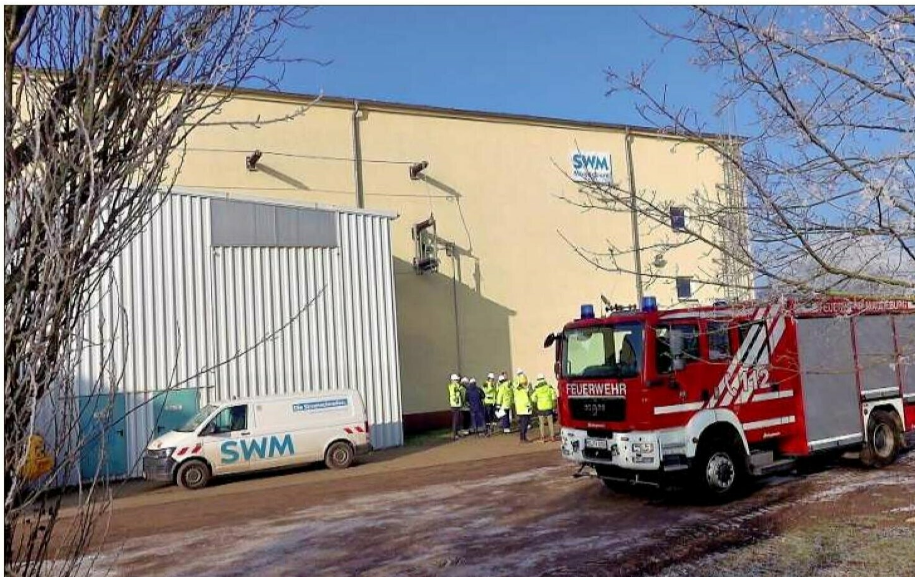
Nach einem tödlichen Unfall im Umspannwerk in Rothensee kamen auch die Feuerwehr und Rettungskräfte zum Einsatz. In Rothensee fiel gestern für fast eineinhalb Stunden der Strom aus, auch die Fernwärmeversorgung war betroffen.
