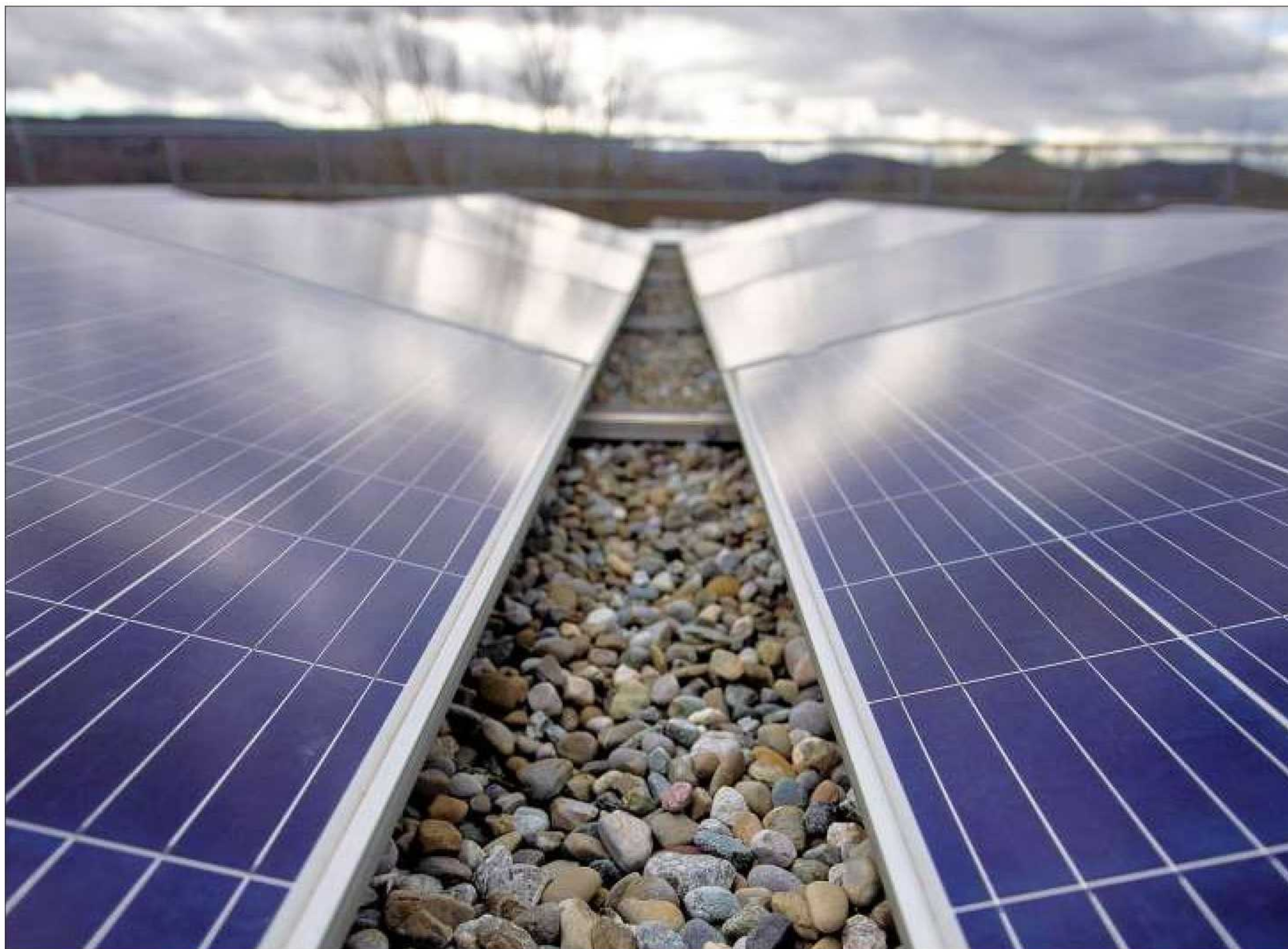
Im Gewerbegebiet Nord soll auf einer 1,8 Hektar großen Brachfläche eine Photovoltaik-Anlage errichtet werden. Der Strom soll in Wasserstoff umgewandelt und beispielsweise für Fahrzeuge genutzt werden.
