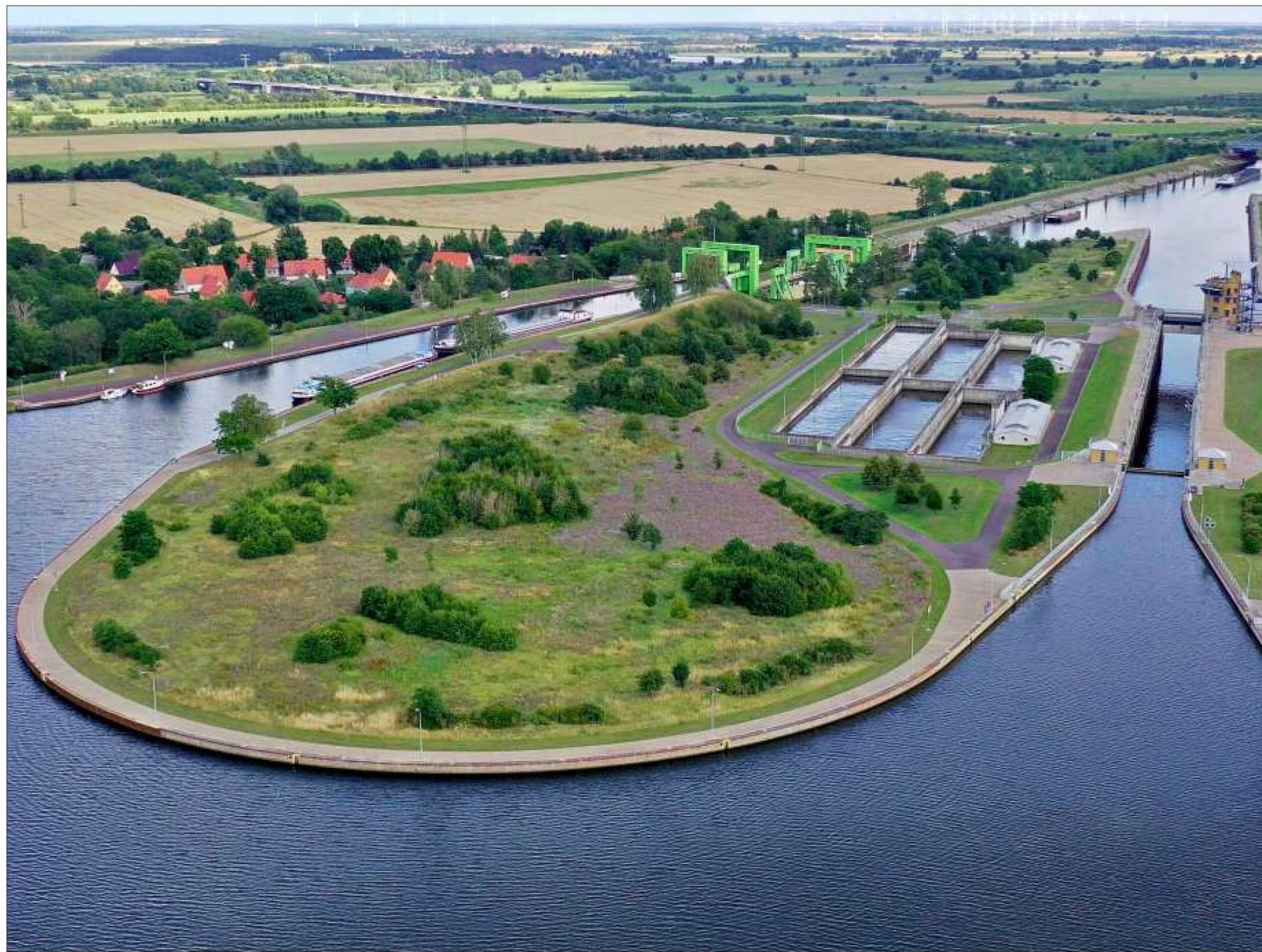
Die Schleuseninsel mit Sparschleuse (rechts) und Schiffshebewerk. Auf der freien Fläche im Vordergrund soll die geplante Großleitzentrale entstehen. In der Zentrale soll auch das Besucherinformationszentrum für das Wasserstraßenkreuz und das Schiffshebewerk untergebracht werden.
