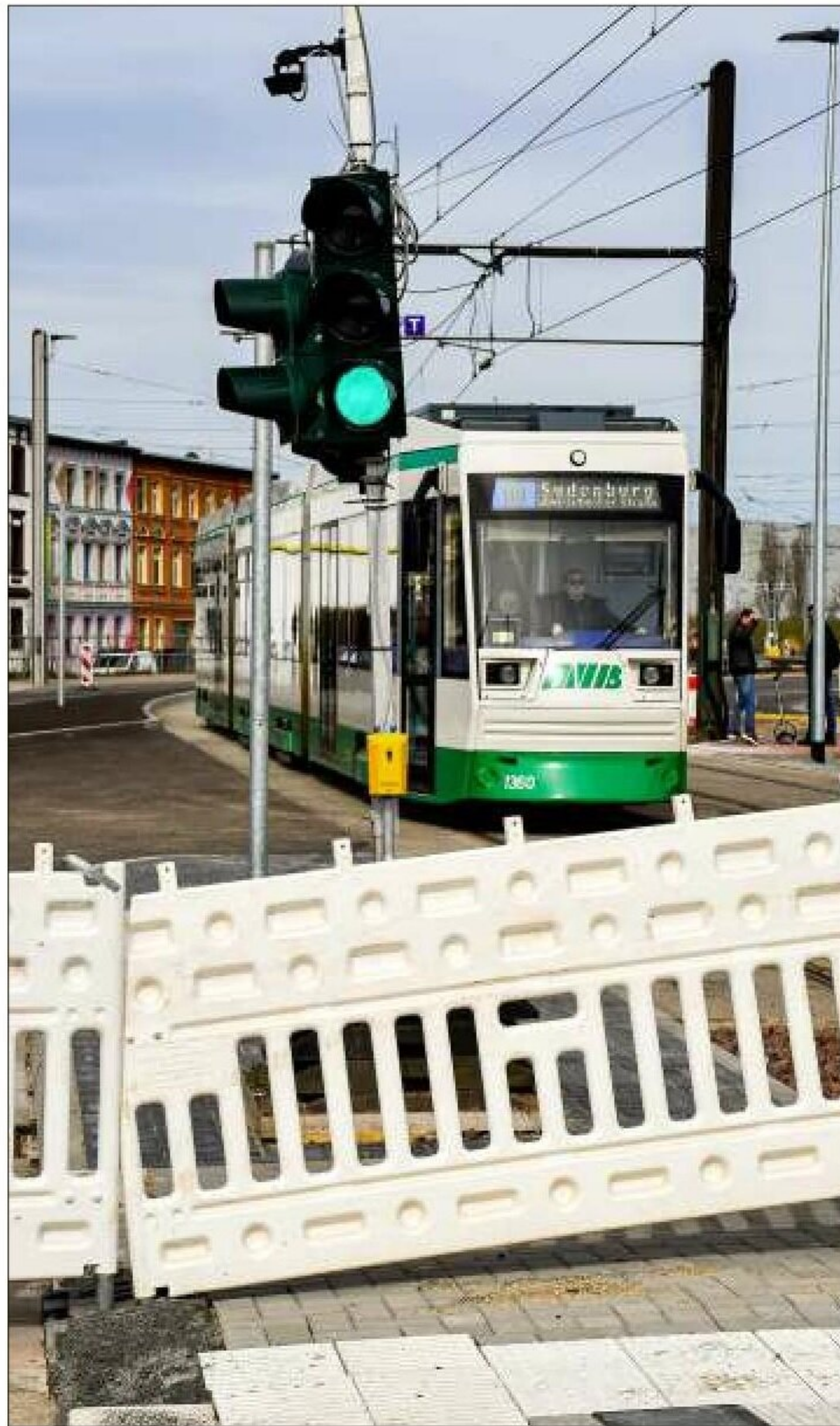
Wegen Lieferschwierigkeiten gibt es aktuell Bauverzug bei der MVB-Baustelle auf dem August-Bebel-Damm.
