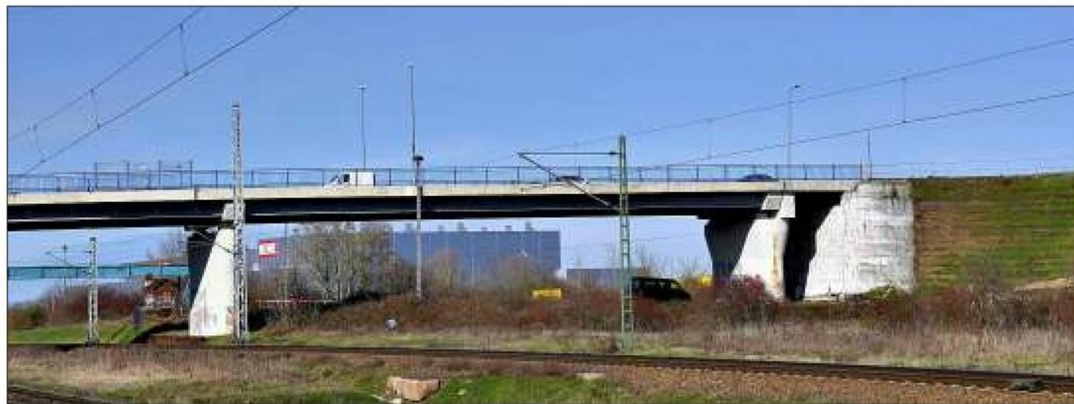
Die Brücke über die Eisenbahngleise an der Oebisfelder soll nun voraussichtlich erst Mitte April wegen Sanierungsarbeiten gesperrt werden.
