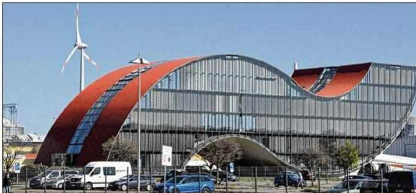
Markantes Wahrzeichen der Enercon-Aktivitäten in Magdeburg ist das Verwaltungsgebäude am August-Bebel-Damm. Foto: Martin Rieß
