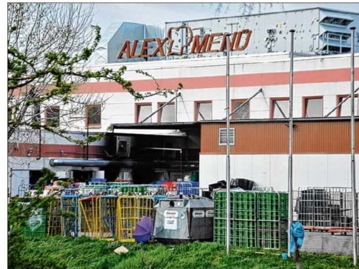
Das Feuer richtete in einem Anbau des Objektes an der Parchauer Straße einen Millionenschaden an. Fotos: Marco Papritz
