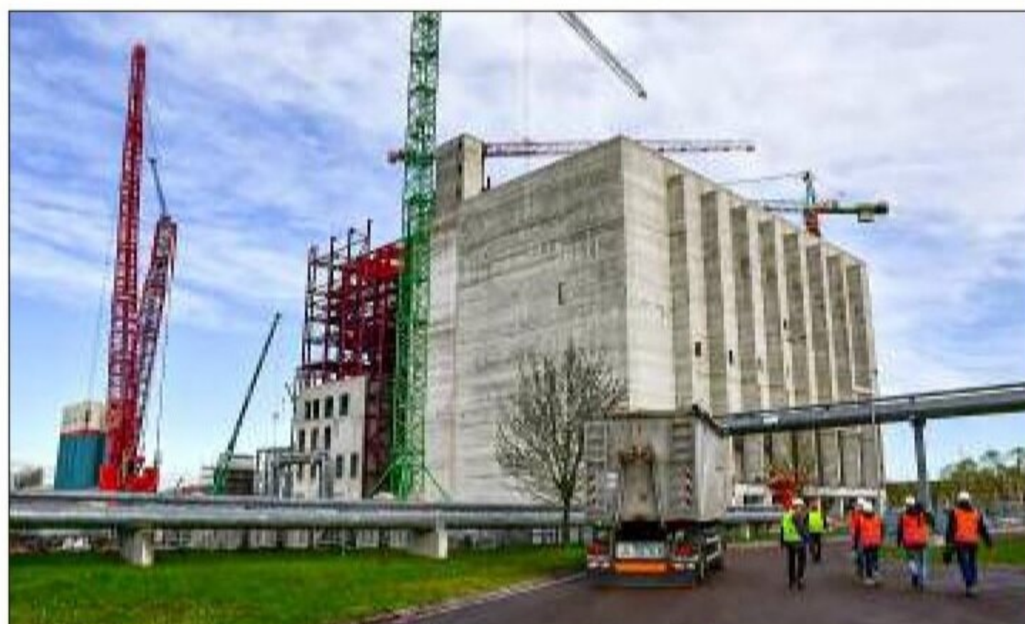
Seit gut einem Jahr wird am Block 3 gebaut. Ende 2024 soll hier Abfall in Fernwärme und Energie umgewandelt werden.
