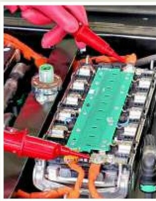
Bis zu 800 Volt Spannung hat eine E-Auto-Batterie. Foto: BLC
