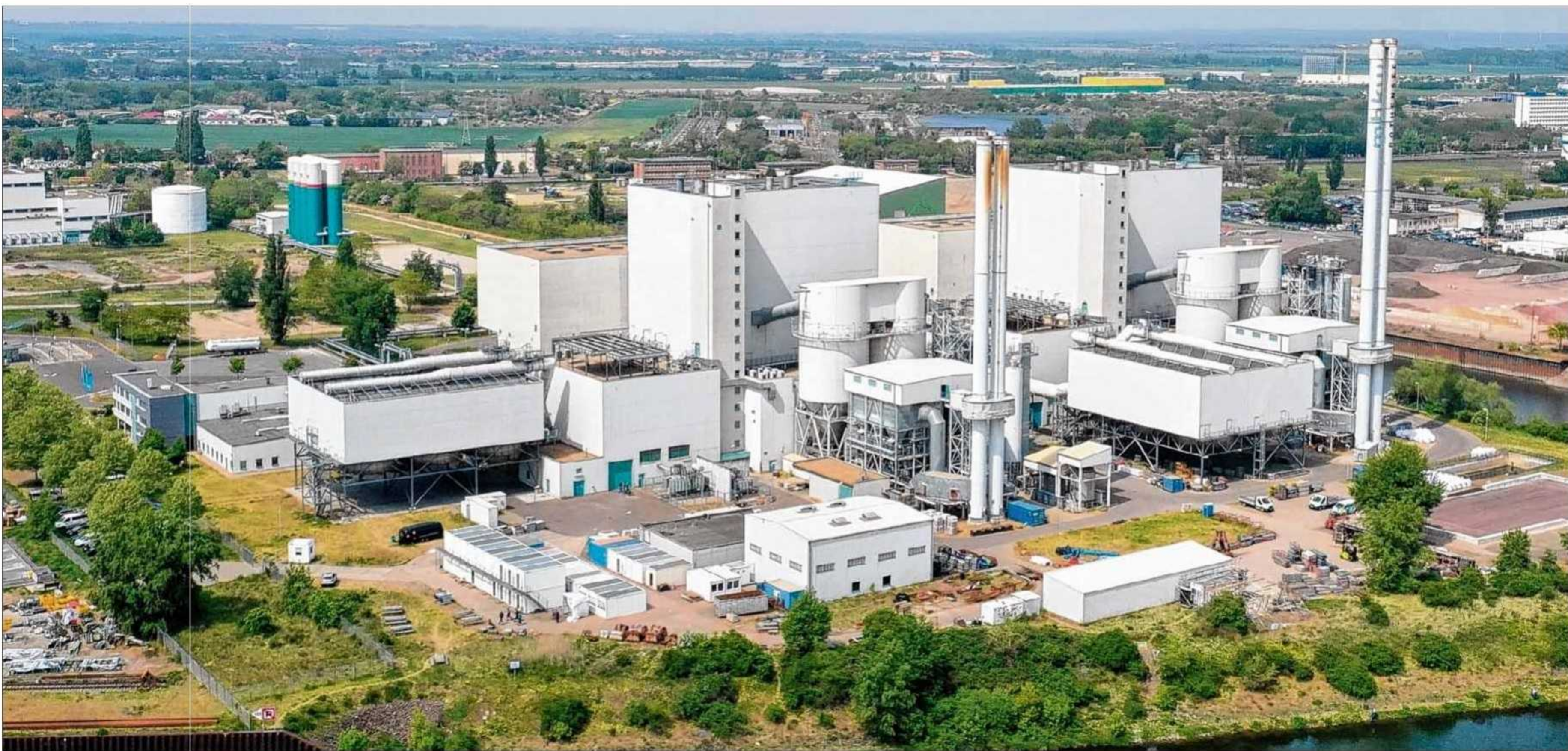
Das Müllheizkraftwerk Rothensee aus der Vogelperspektive. Auch in Corona-Zeiten wird hier rund um die Uhr Strom und Fernwärme aus Müll erzeugt. Mit einigem Aufwand sind im MHKW zudem geplante Instandsetzungsarbeiten abgeschlossen worden. Foto: Eroll Popova
