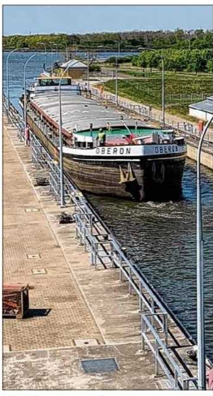
Die Oberon wurde als erstes Schiff in der reparierten Schleuse Rothensee geschleust. Foto: WSA
