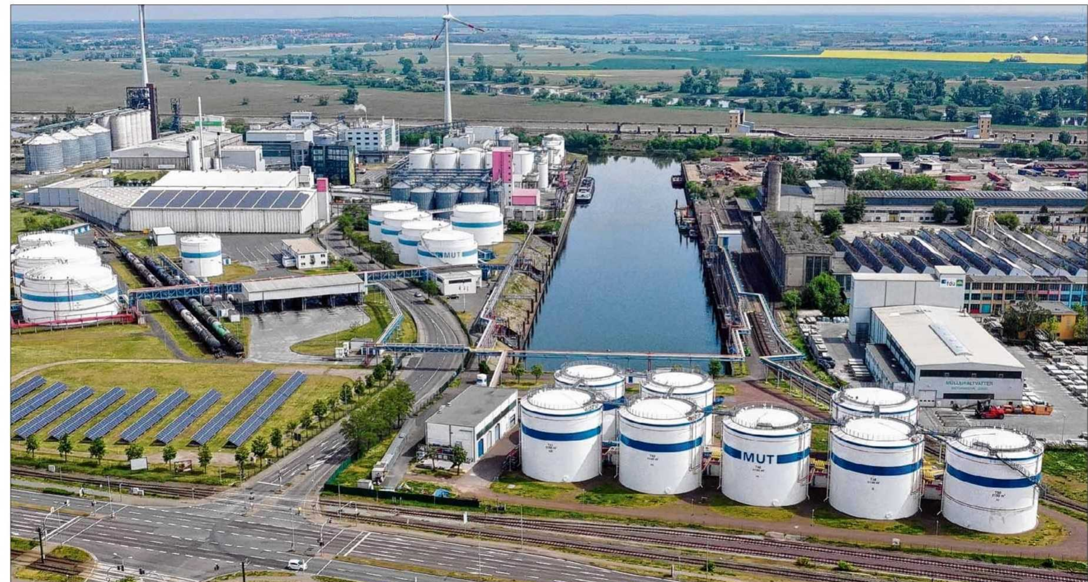
Im Hafenbecken II ist eine Investition von rund sechs Millionen Euro geplant. Hier muss eine 300 Meter lange Spundwand erneuert werden.
