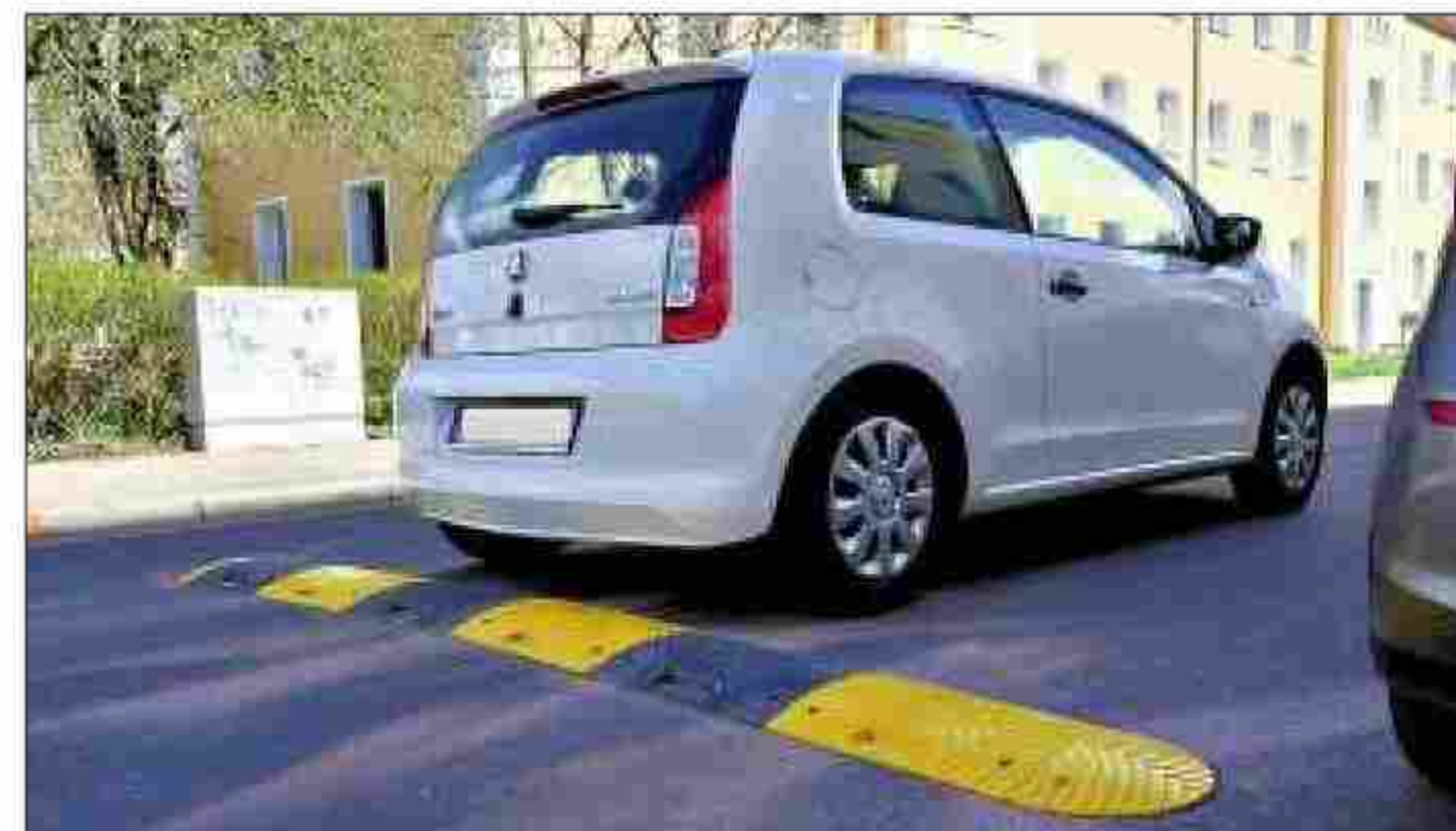
Die erst im Frühjahr installierten Bodenschwellen in der Oebisfelder Straße wurden wieder entfernt.
