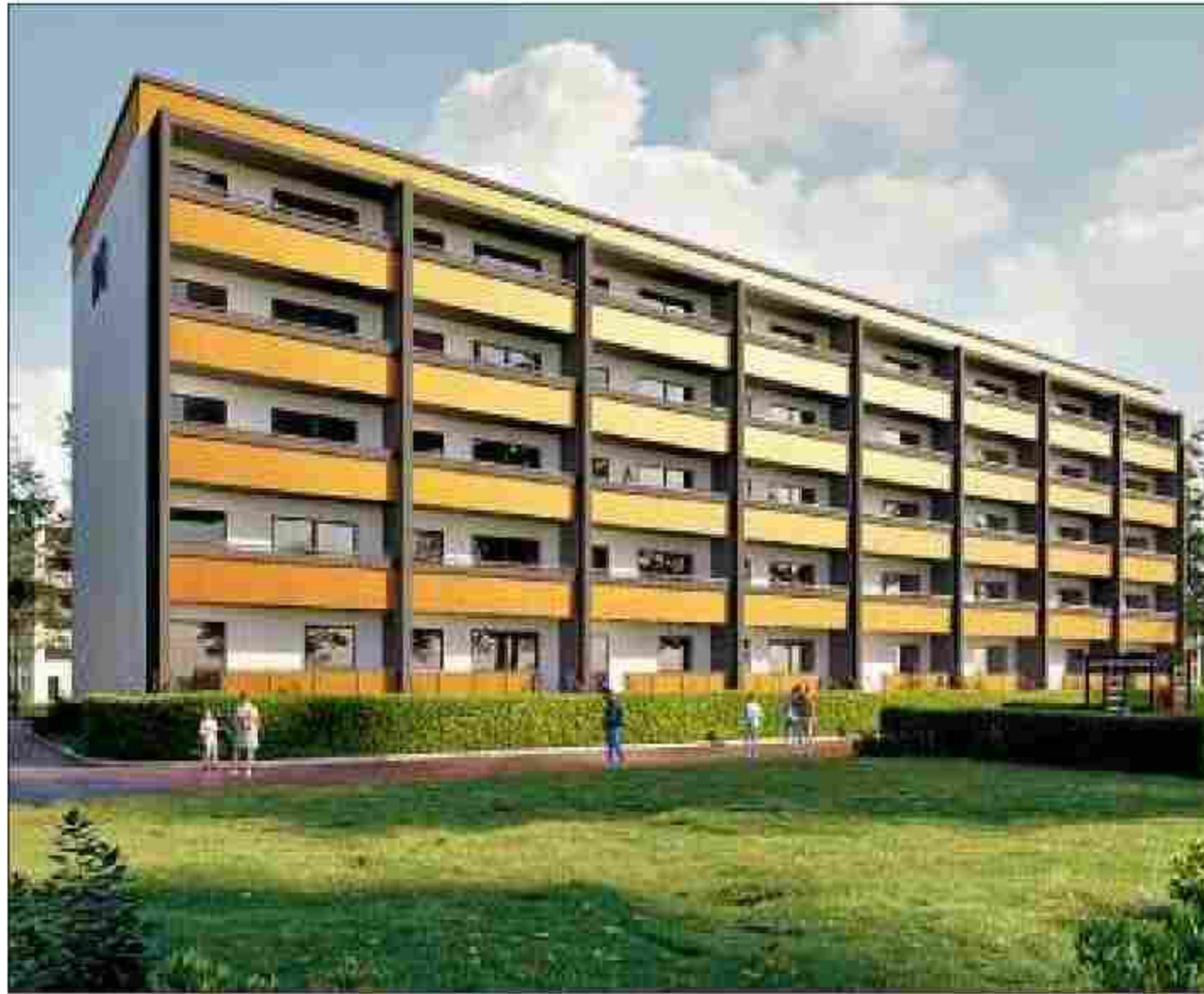
Der Plattenbau an der Badeteichstraße wird als „Rothensee Quartier“ entwickelt.
