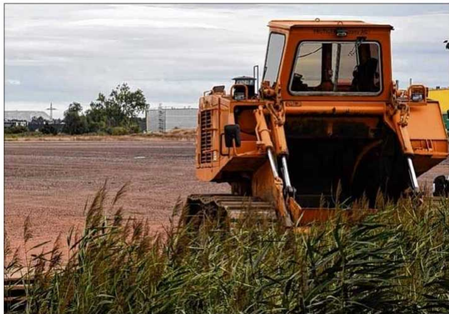
An der Burger Straße laufen die Bauvorbereitungen für das neue Rewe-Zentrallager. Foto: Stefan Harter
