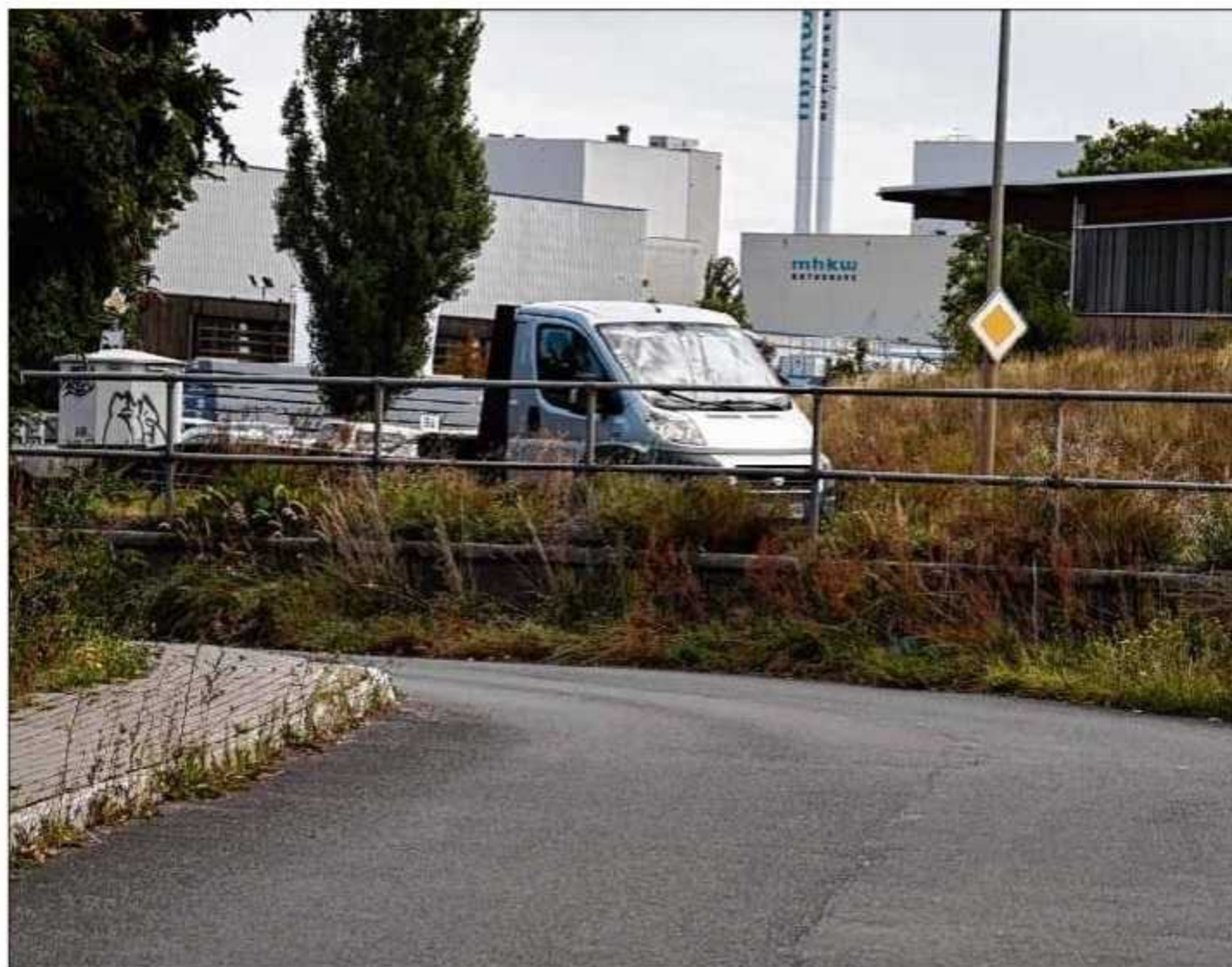
Blick von der Scheidebuschstraße in Richtung August-Bebel-Damm. Hier soll eine provisorische Rampe für Lkw gebaut werden.
