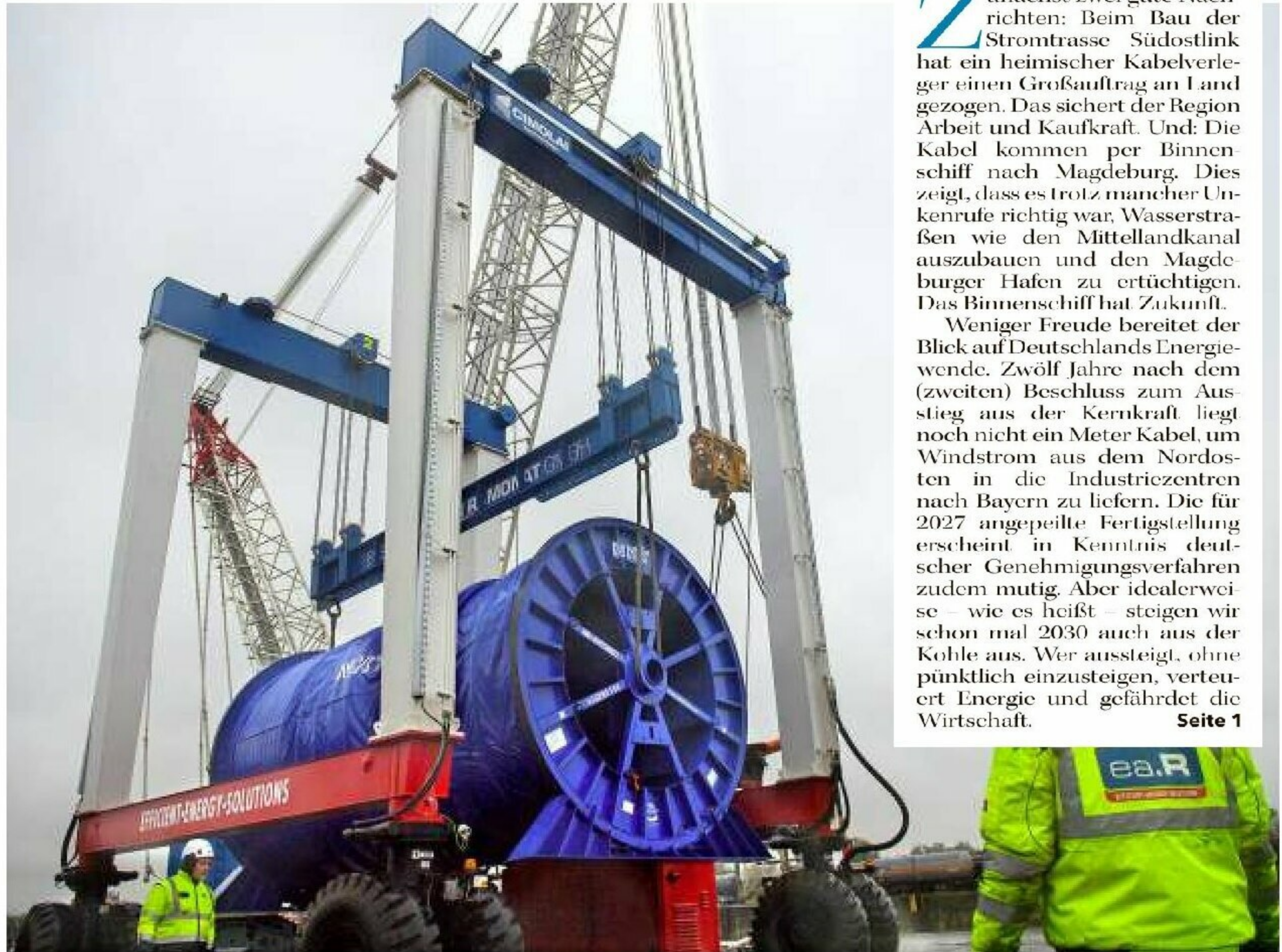
Eine Spule mit Gleichstromkabel wird am Hafen Magdeburg angeliefert.
