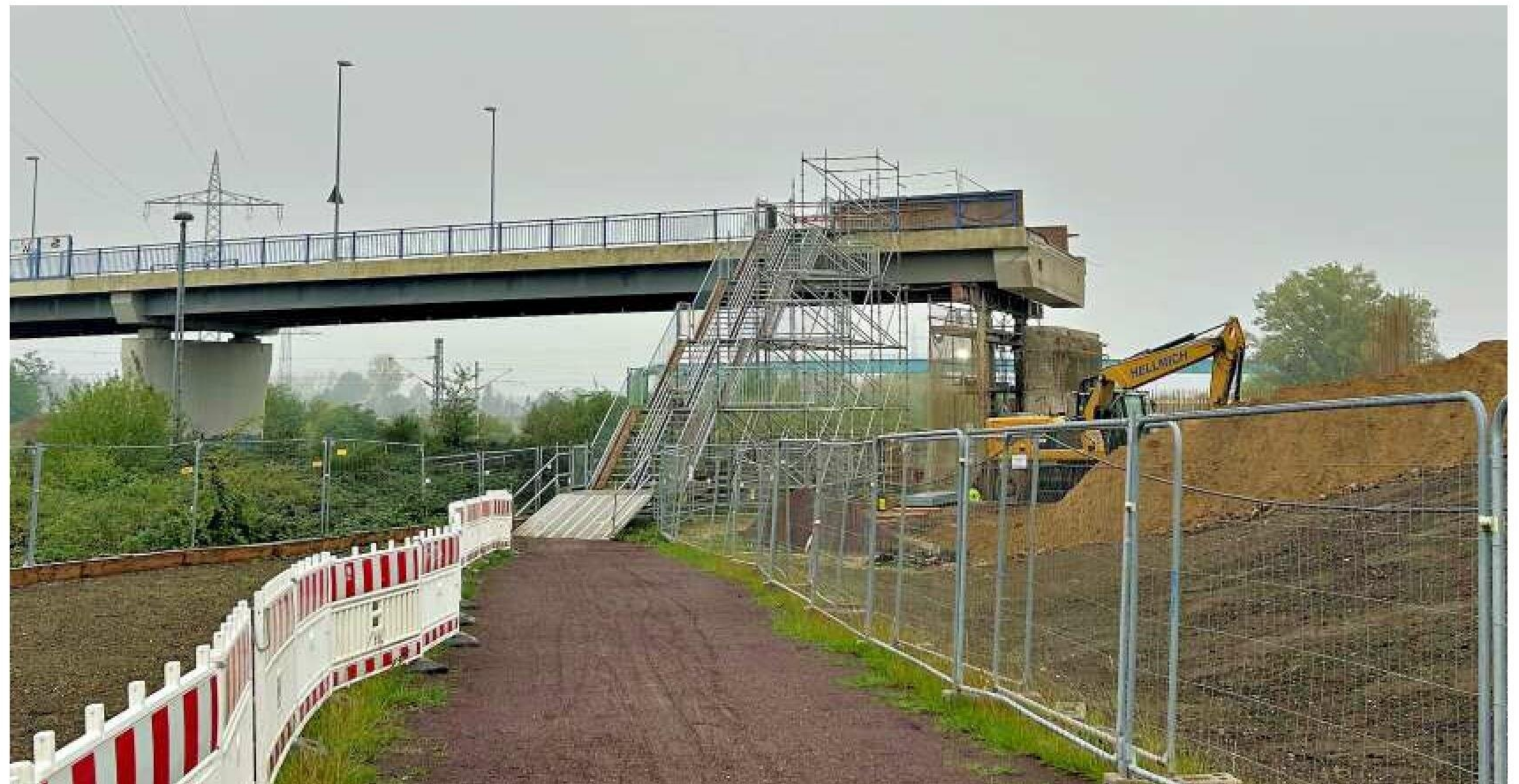
Ein Fuß- und Radweg führt an der Baustelle vorbei. Das Foto zeigt den aktuellen Stand der Baustelle an der Oebisfelder Straße.
