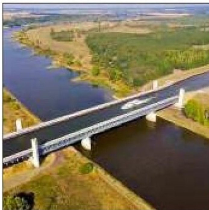
Das Wasserstraßenkreuz, hier die Trogbücke, feiert Geburtstag.
