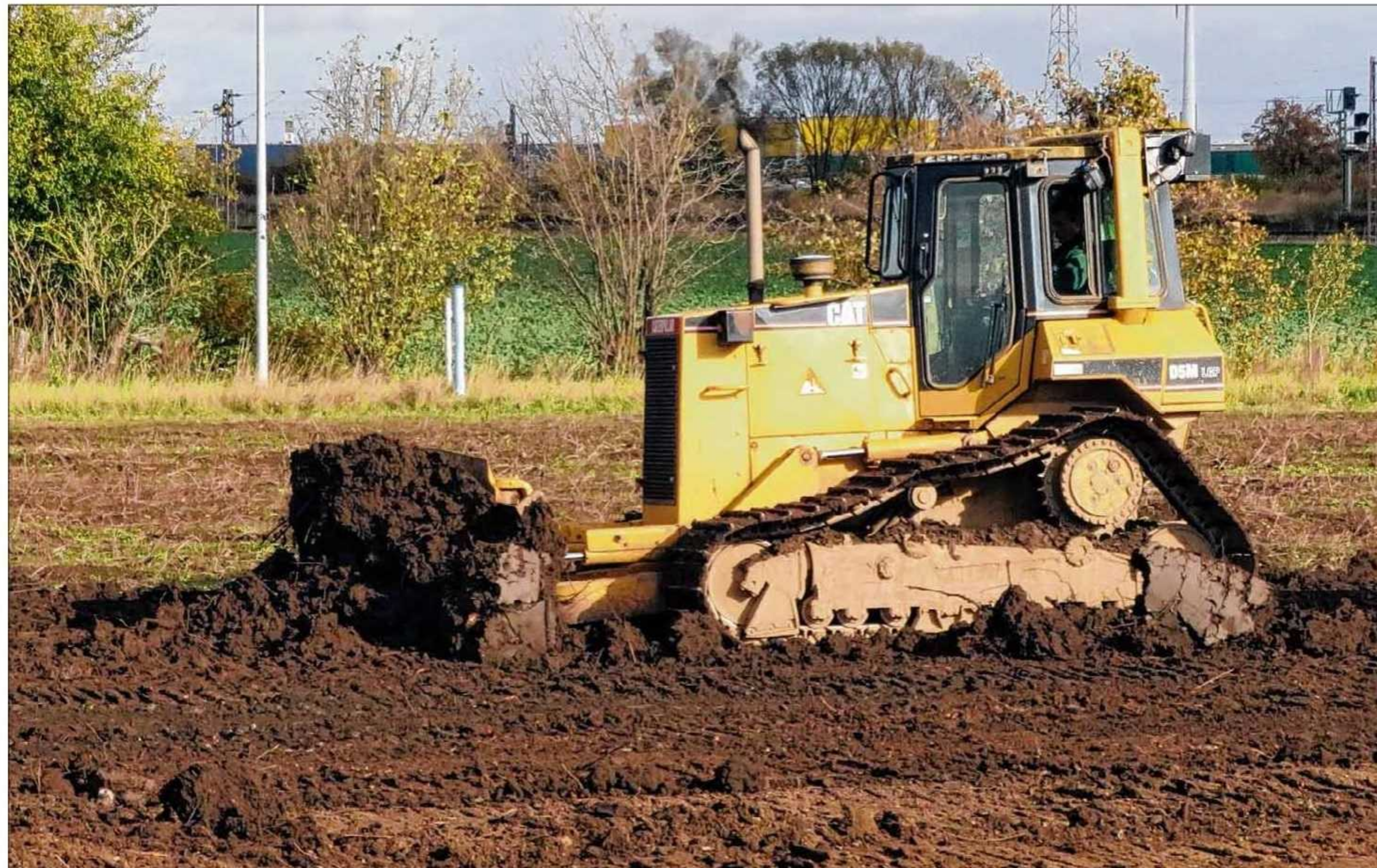
Mit einem Raupenfahrzeug wurde die Fläche an der Oebisfelder Straße vorbereitet. Die ersten Bäume kommen demnächst.
