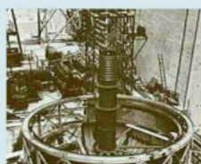
Montage eines Schwimmers für das Schiffshebewerk.
