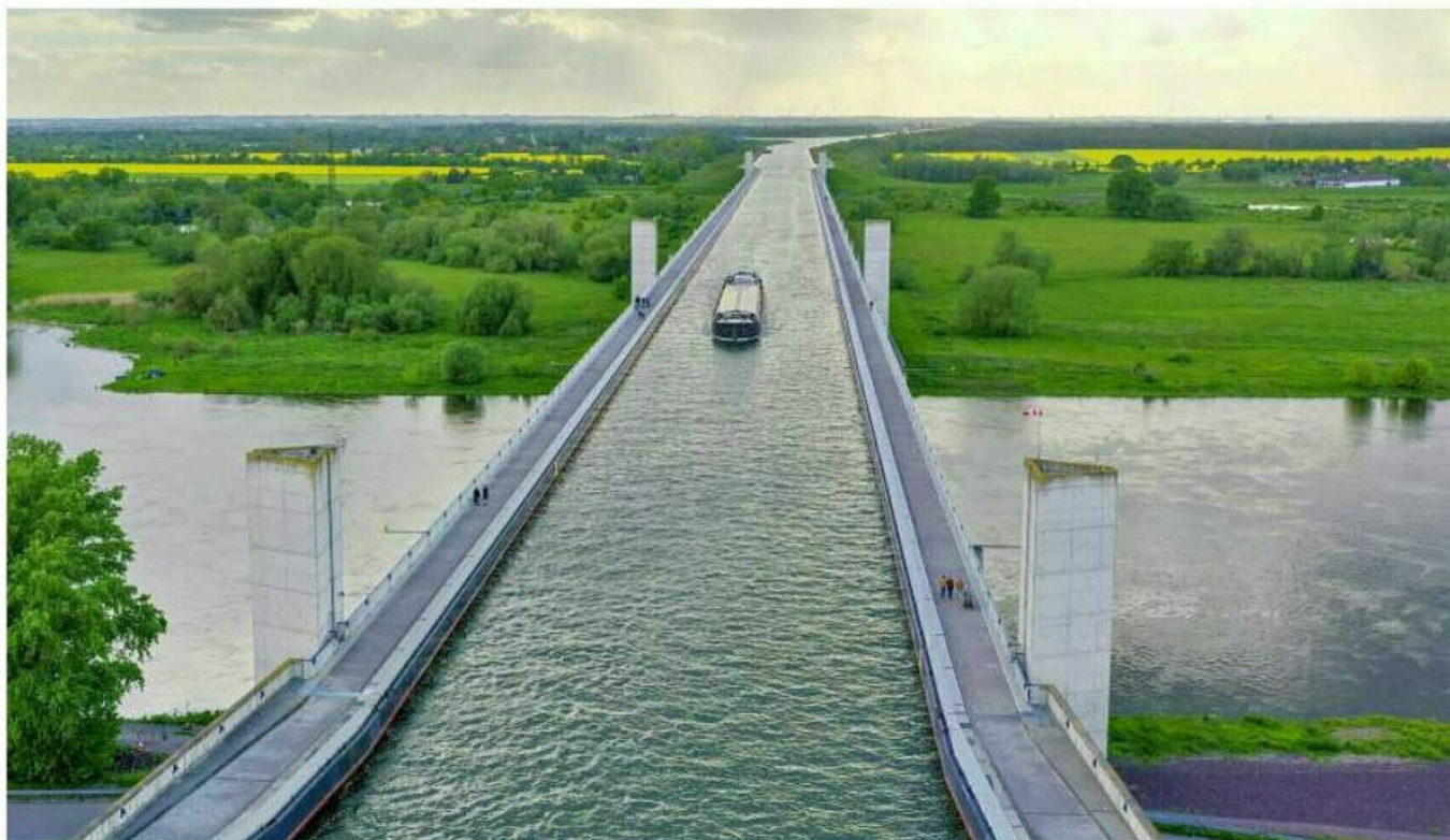
Ein Binnenschiff überquert das Wasserstraßenkreuz Magdeburg. Der Mittellandkanal führt an dieser Stelle in einer Trogbrücke über die Elbe. Sie ist mit einer Länge von 918 Metern die größte Kanalbrücke Europas. FOTO: DPA
