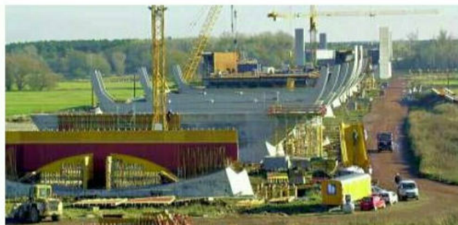
Bild von den Bauarbeiten der Trogbrücke im Jahr 2000.
