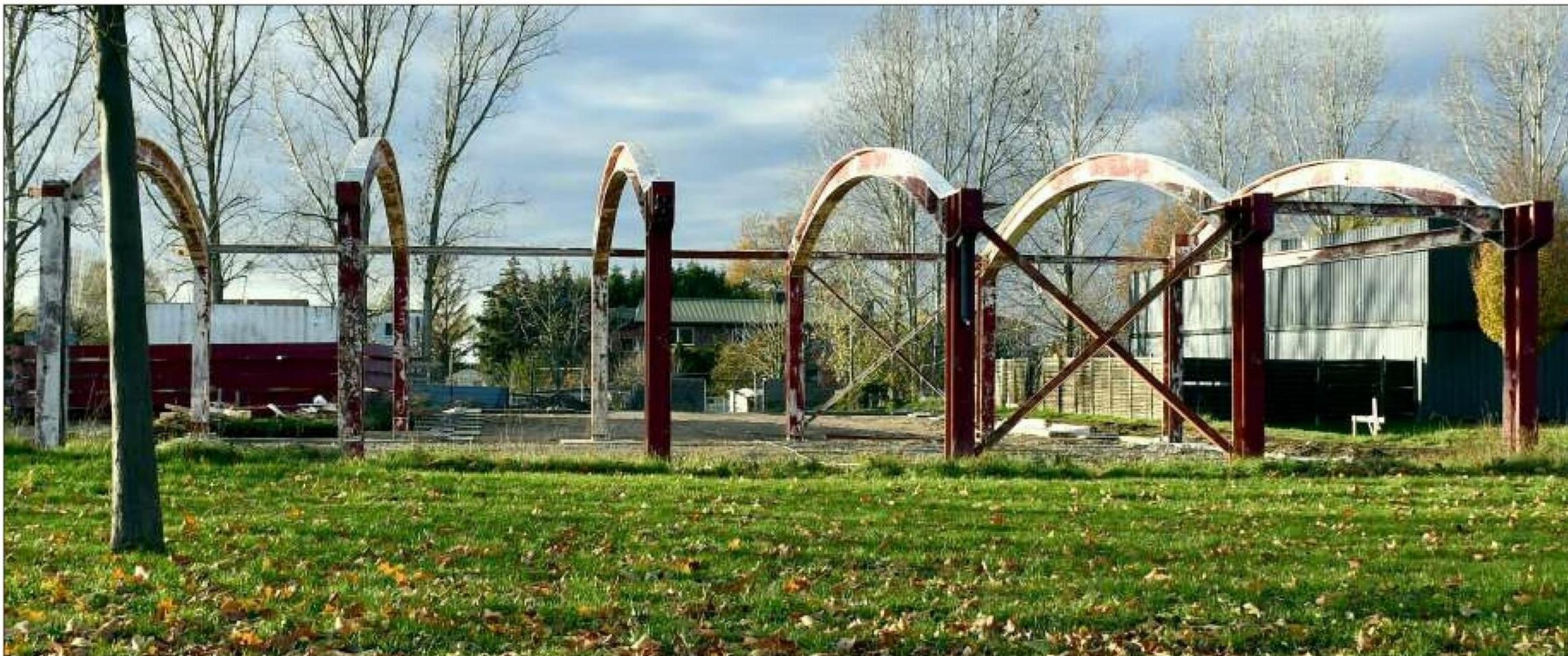
Am August-Bebel-Damm wird eine neue Industriehalle errichtet. Das Besondere: Die verwendeten Stahlträger und weiteren Bauteile werden zweitverwendet. Sie stammen aus einer ehemaligen Siemens-Werkshalle aus Coburg.
