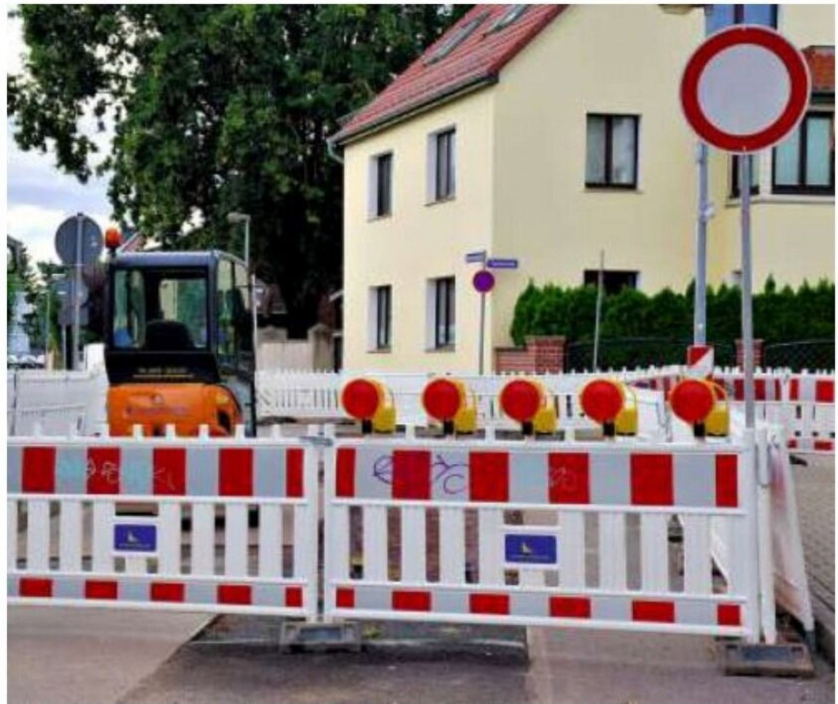
Eine SWM-Baustelle in der Badeteichstraße in Rothensee wandert zum nächsten Bauabschnitt.
