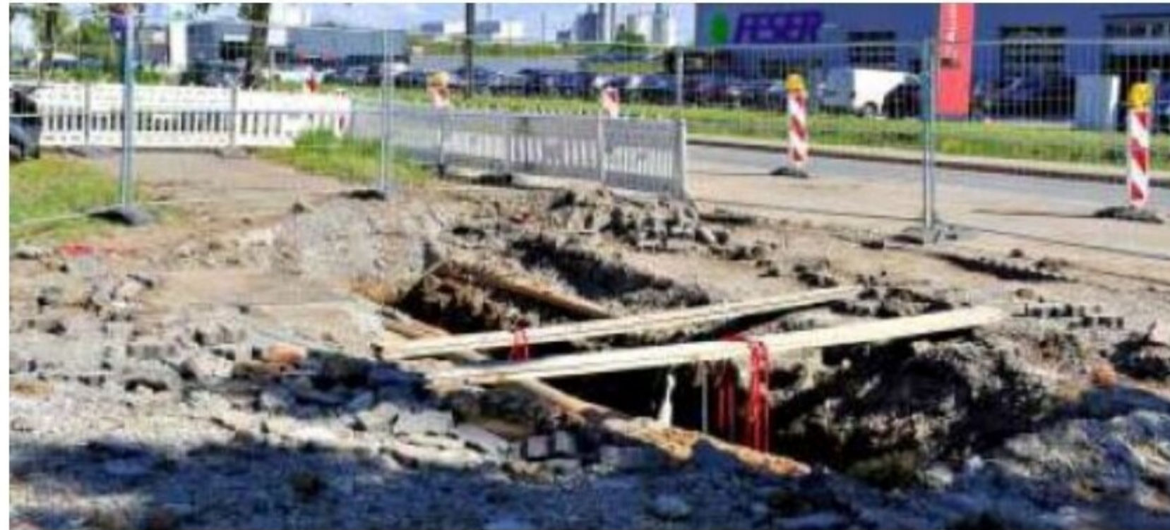
Nach dem Rohrbruch im Magdeburger Stadtteil Rothensee laufen die Reparaturarbeiten.
