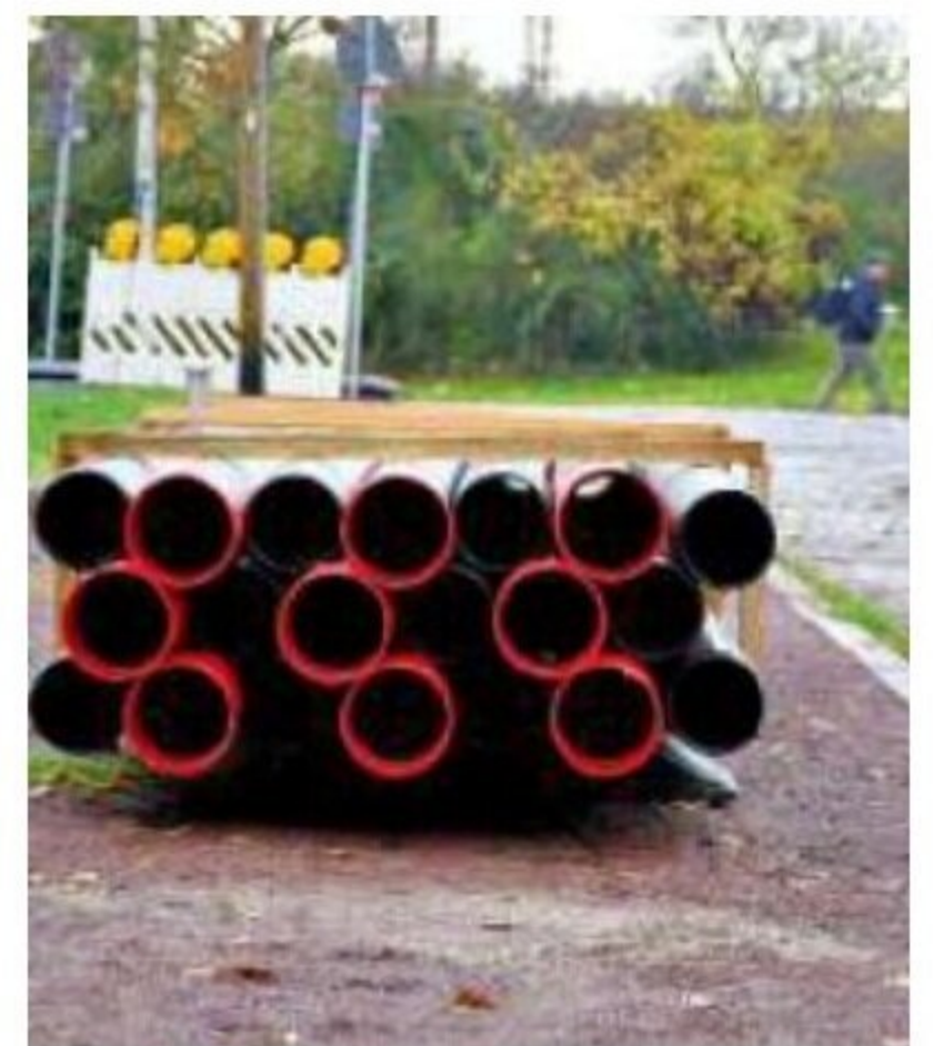
Zu sehen sind die noch zu verlegenden Leerrohre für die neue Stromleitung.
