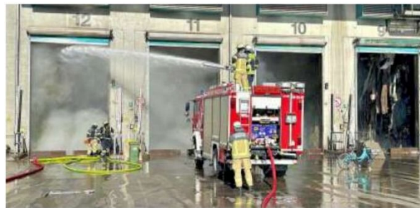
Im Müllheizkraftwerk Magdeburg-Rothensee muss immer wieder die Feuerwehr anrücken. Auslöser der Bunkerbrände seien Batterien und Akkus, sagt der Betreiber und appelliert für deren richtige Entsorgung. FOTO: MHKW
